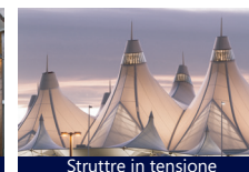
Strutture in tensione
